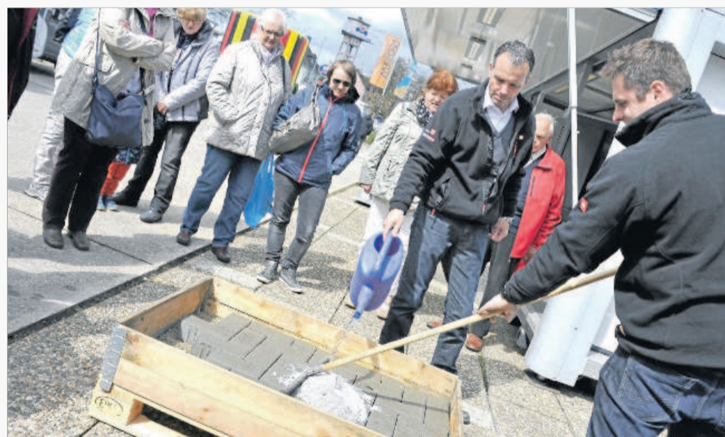
Auf viel Interesse stieß die Vorführung mit dem neuen Pflasterfugenmörtel von Tubag, der besonders unkompliziert eingebracht werden kann und auch für besonders schmale Fugen geeignet ist.
